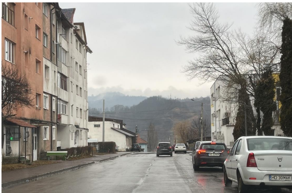
Figura nr. 10 - Prospect stradal - Strada Jiului 8
