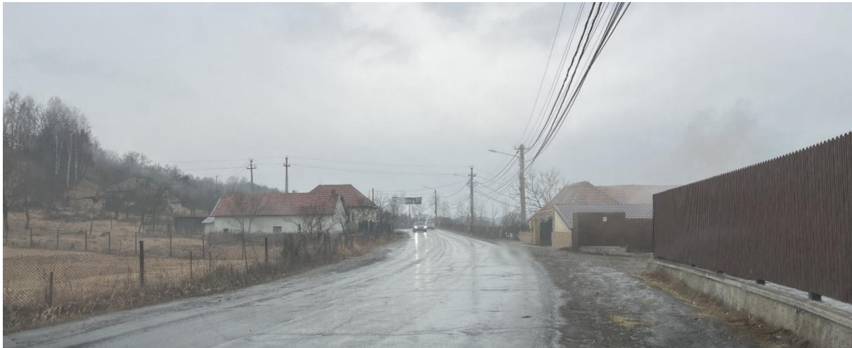
Figura nr. 6 - Prospect stradal - drum național DN 66A 4
